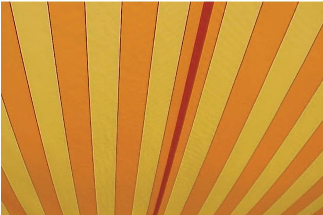
Bild 9.1.8 Tillåten vågighet nära skarven (bikakebildning)
